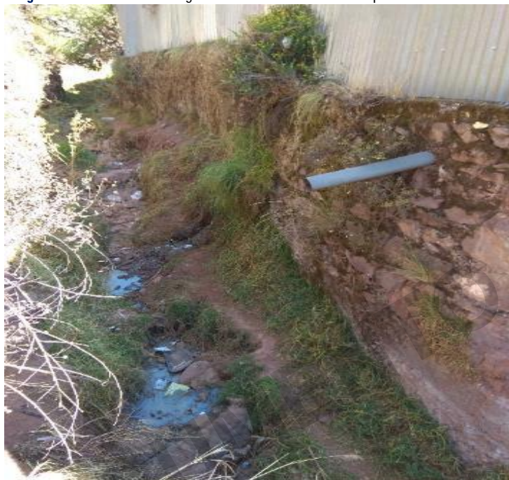
Imagen N° 45: Vertimiento de aguas residuales no tratadas a la quebrada.
