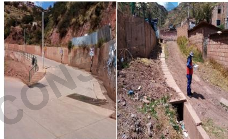
Imagen N° 22: Vías en la que se encuentran sumidero y canal para aguas pluviales
