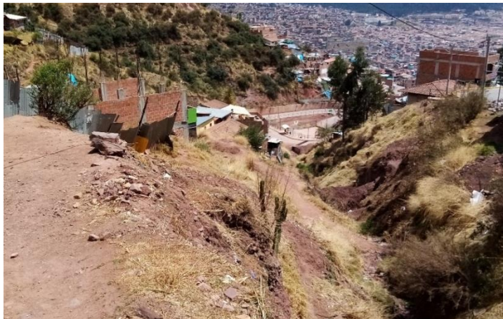
Imagen N° 21: Acumulación de escombros en la Quebrada Ranachayoc
